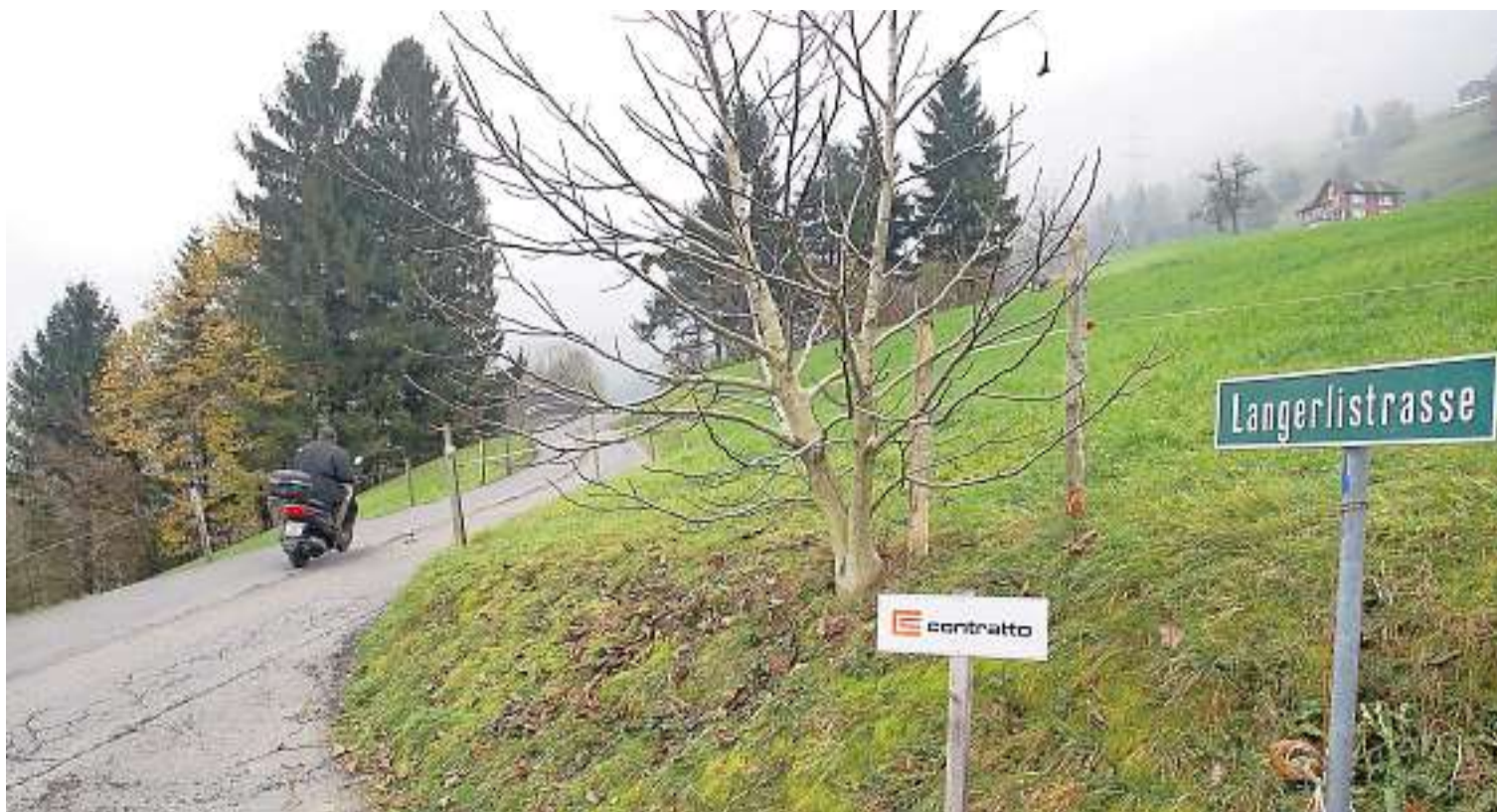
Grundwasserschutz steht der Verstärkung der Bergstrasse im Weg: Auf diesem und einem weiteren kurzen Teilstück kann der Strassenuntergrund nicht genügend verstärkt werden, weil die dafür notwendigen Abgrabungen eine Gefahr für zwei Quelfassungen darstellen würden. Die Oberallmeind schlägt einen Kompromiss vor. Bild Franz Steinegger
